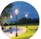
Основное освещение: Высота опоры 2,5-3м
