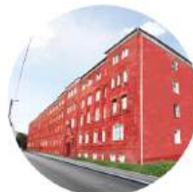
7. Ремонт объекта капитального строительства по улице Лесопильная, 73-79
