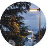
Основное освещение: Высота опоры 2,5-3м
