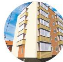
8. Ремонт объекта капитального строительства по улице Литовский Вал, 89а.
