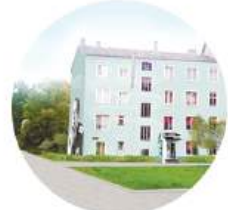
6. Ремонт объекта капитального строительства по переулку Литовский, 16-18
