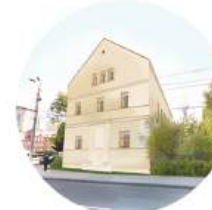
5. Ремонт объекта капитального строительства по проспекту Московский, 162
