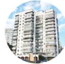
2. Ремонт объекта капитального строительства по улице Литовский Вал, 23
