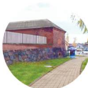
3. Реставрация бастиона «Литва» и благоустройство прилегающей территории
