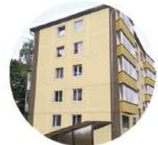
3. Ремонт объекта капитального строительства по улице Литовский Вал, 52-58
